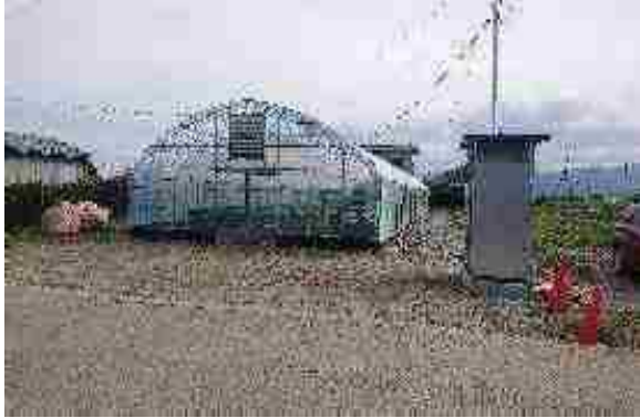
高床式砂栽培ハウス新設
