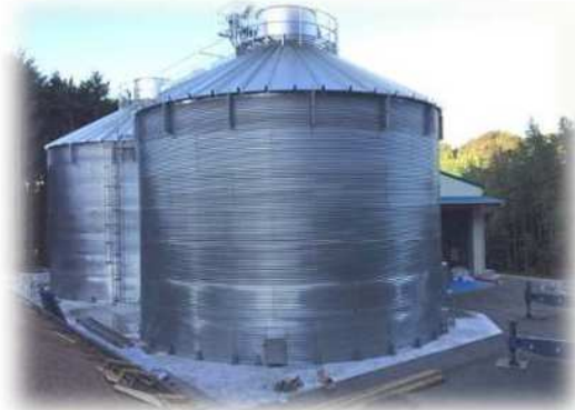
平成28年に完成した飼料用米保管タンク350t×2基
