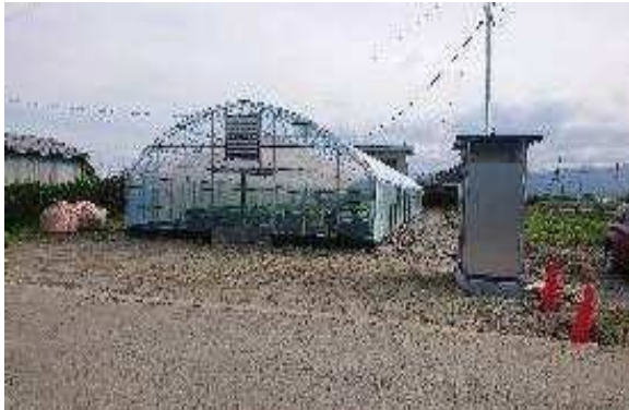
高床式砂栽培ハウス新設
