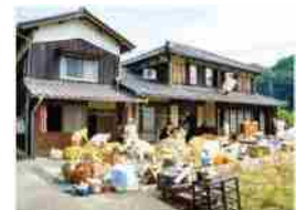
移住者受入のための空き家を整備
