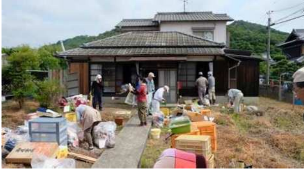
移住者受入れのための空き家を整備
