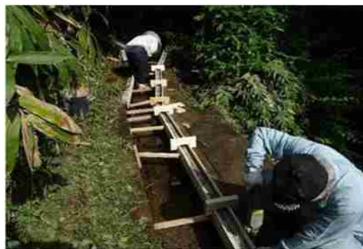
水路の補修作業
