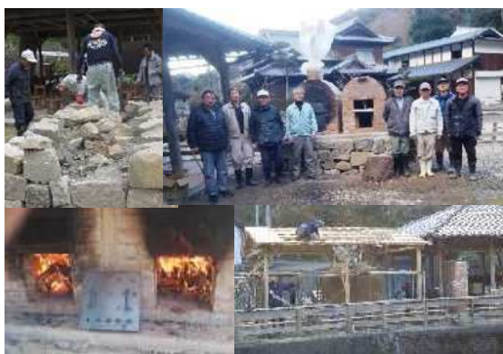
ピザ石窯・建屋を手づくりで建設
