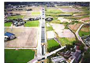
香川用水幹線水路・開水路区間
