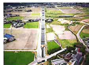
香川用水幹線水路・開水路区間
