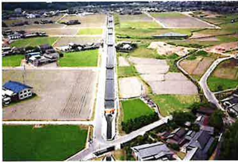
香川用水幹線水路・開水路区間
