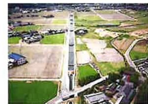
香川用水幹線水路・開水路区間
