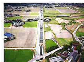
香川用水幹線水路・開水路区間
