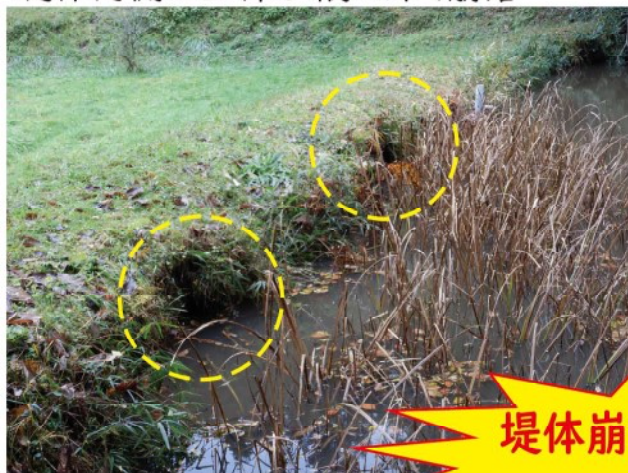
堤体内側の上部が縦に深く崩落
