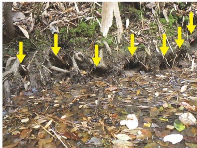
堤体内側の上部が横に長く崩落
