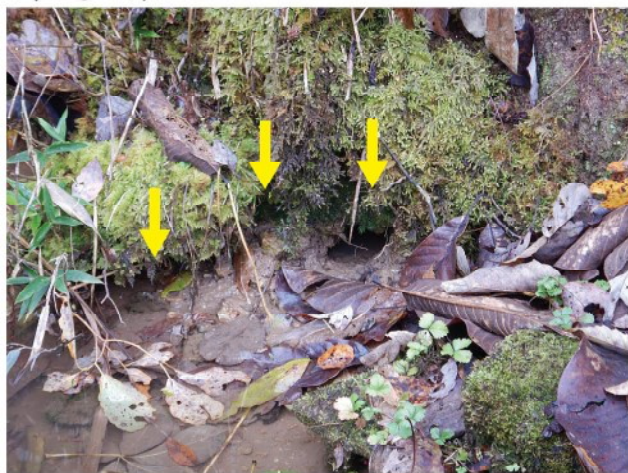
堤体内側の上部が縦に深く崩落
