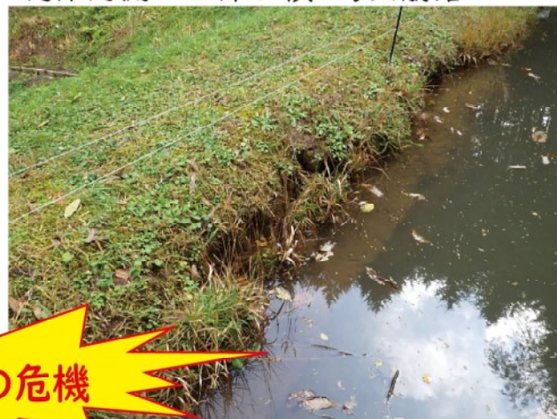
堤体内側の上部が横に長く崩落
