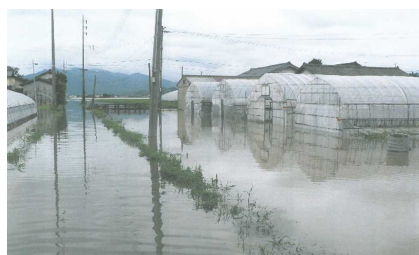
降雨によるハウス湛水
