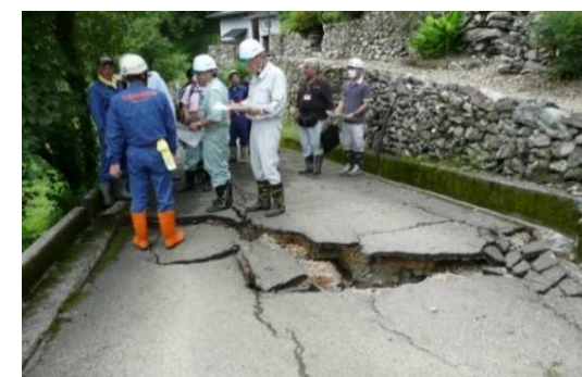
災害復旧工法の現地検討
