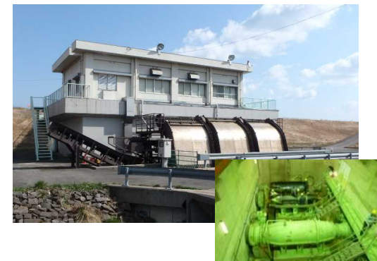
揖屋排水機場
