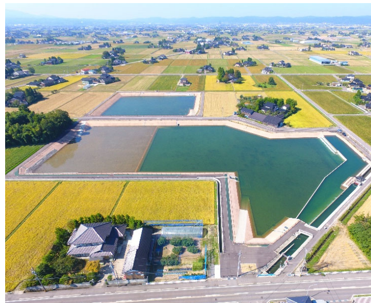
洪水から農村地域を守る調整池や排水路
