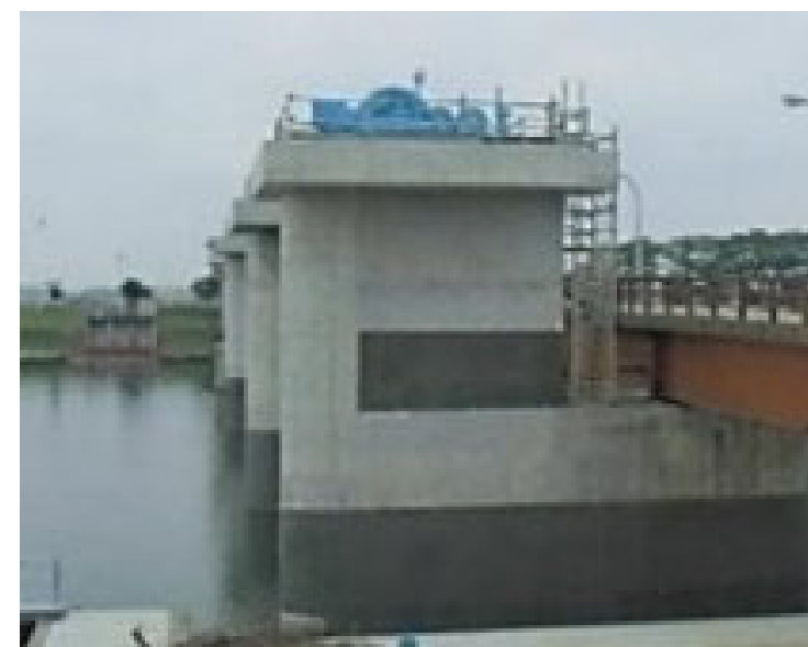
頭首工の耐震化(堰柱の拡幅)
