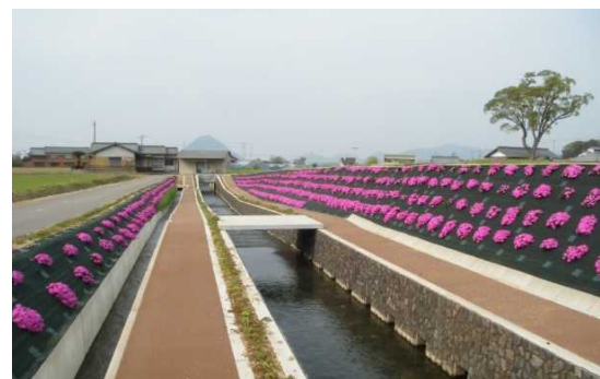
環境水路工（遊水池、遊歩道整備）
