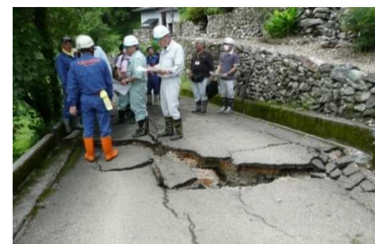
災害復旧工法の現地検討
