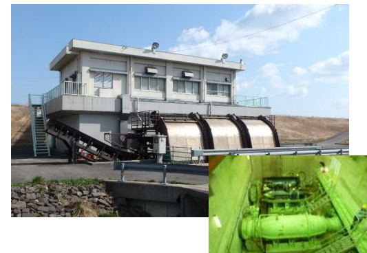
揖屋排水機場
