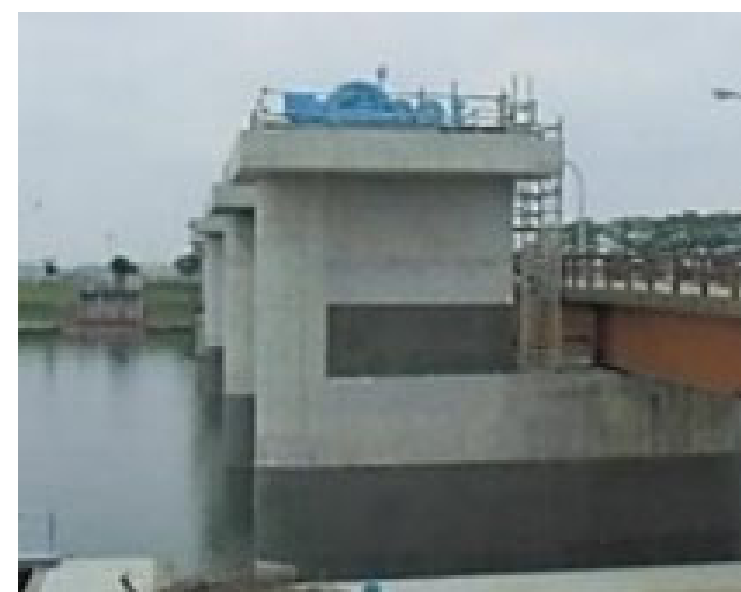
頭首工の耐震化(堰柱の拡幅)
