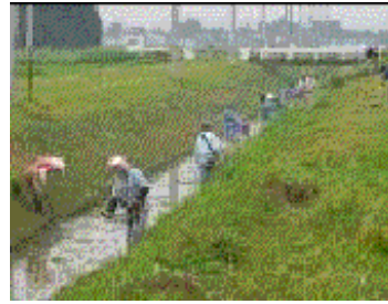
水路の泥上げ
