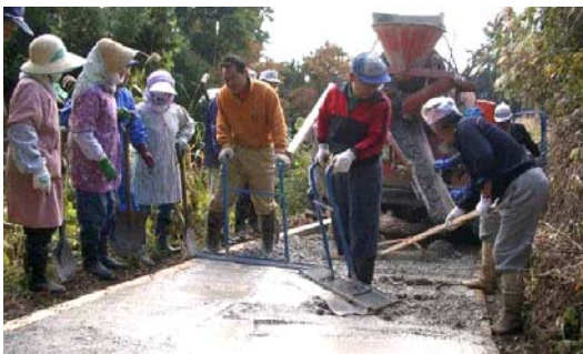
道路を住民がコンクリート舗装
