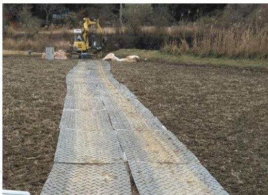
③ 硬質プラスチック板の設置状況
