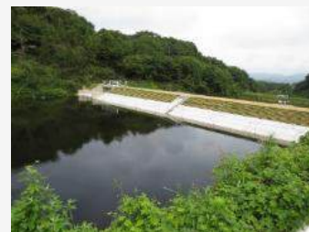
整備後のため池
