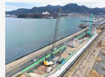
堤防の耐震化(岡山県岡山市)
