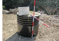
大型排水管を利用した残渣処理
