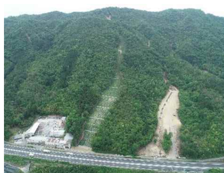
【山腹工】 (広島県東広島市 東広島地区：高屋)
