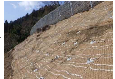
きふねやま 貴船山国有林) 【斜面安定対策工】
