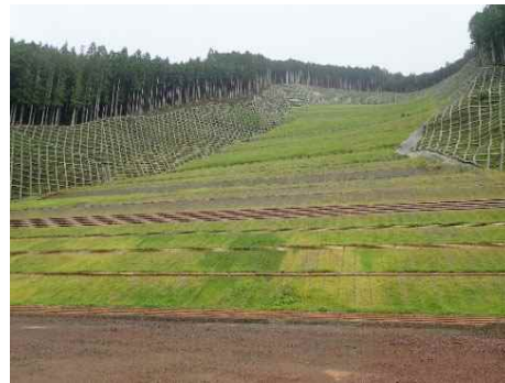
【山腹工】 (奈良県天川村 十津川地区：坪内)
