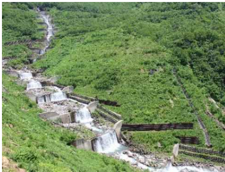
【溪間工・山腹工】 (石川県白山市 手取川地区：湯の谷)
