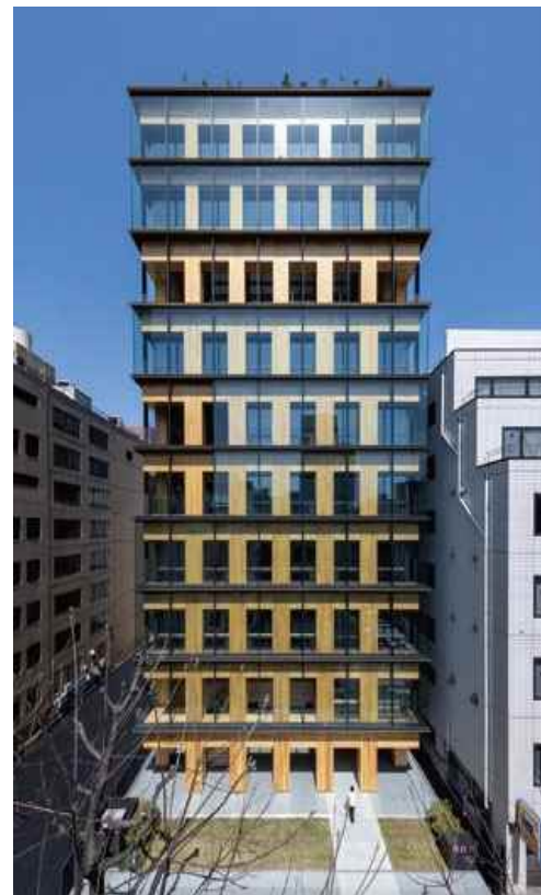
11階建て研修施設 Port Plus (神奈川県横浜市、 2022年竣工)
