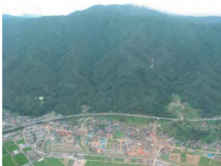
土砂流出防備保安林の全景（長野県諏訪市）
