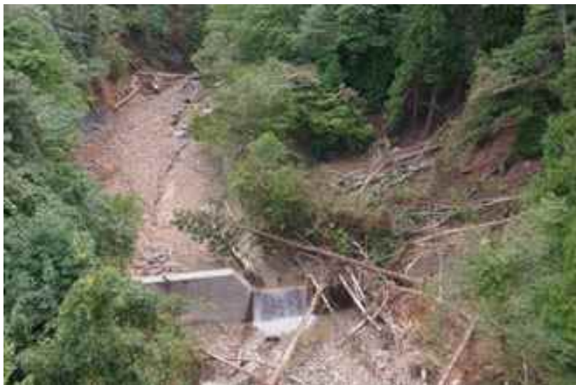
治山施設による土砂や流木の流出抑制 (青森県風間浦村)
