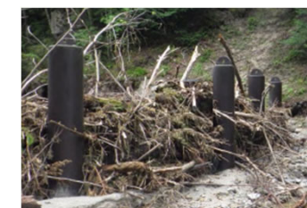
既設治山ダムの堆砂域に鋼管を設置し、流木捕捉機能を付加 （岐阜県恵那市、東濃森林管理署）
