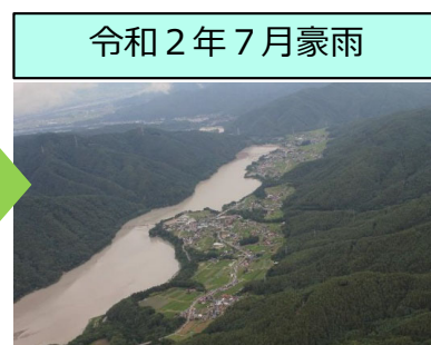
大きな崩壊の発生なし
