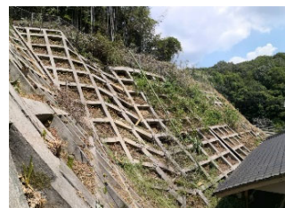
老朽化した施設を更新し、山腹斜面の安定度を向上（広島県尾道市）
