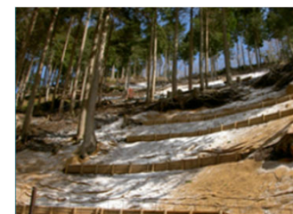
柵工による斜面補強対策
