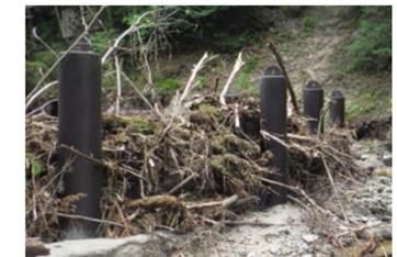
既設治山ダムの堆砂域に鋼管を設置し、流木捕捉機能を付加
