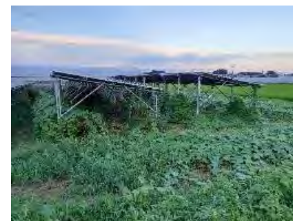
下部農地の管理が適切に行われず、 雑草が繁茂して営農に支障が生じている事例
