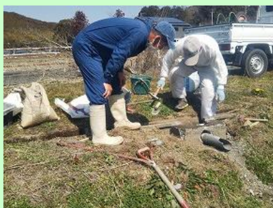
水路破損部分の補修
