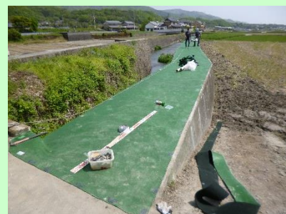
防草シート施工による管理の省力化
