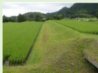
（緩傾斜化された斜面）
