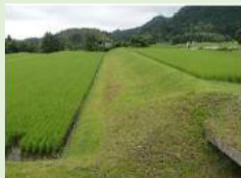
（緩傾斜化された斜面）
