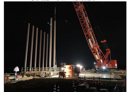
夜間施工状況(杭打設)
