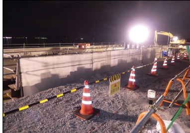
騒音振動対策状況(防音シート設置)
