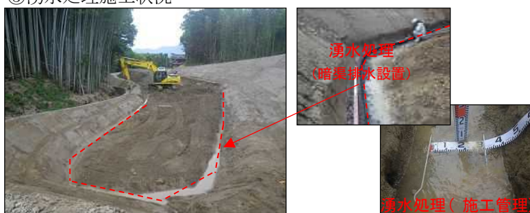
③湧水処理施工状況
