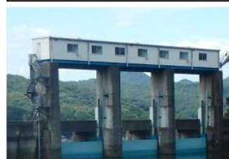
三川ダム_洪水吐ゲート・門柱
