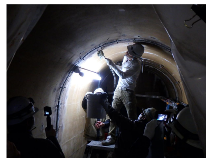
対策工法 (アクリル系二成分合成樹脂系止水材注入) 施工状況
