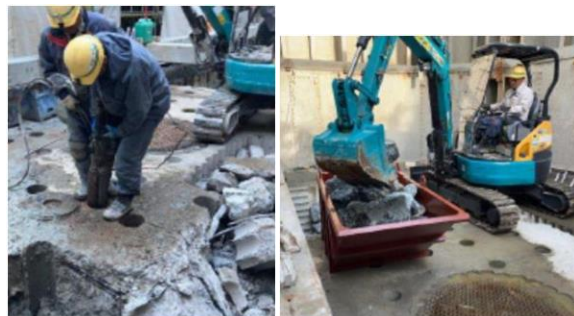
仮締切内エプロン部取壊し状況（写真3）
