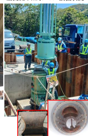
上流側不断水バルブ設置状況
