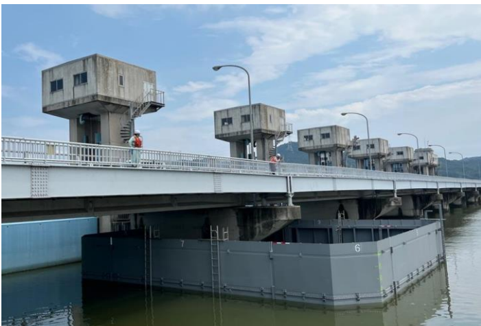
仮締切設置完了（写真1-2）
