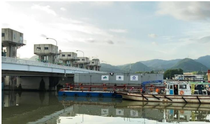
仮締切設置状況（写真1-1）
