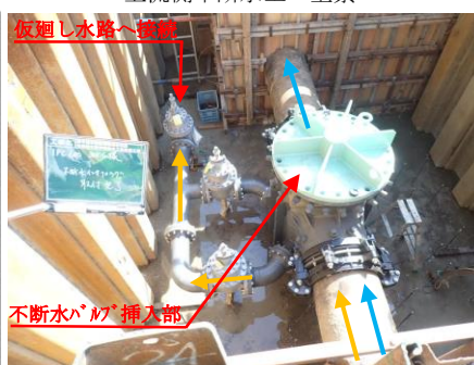
上流側不断水工 全景
