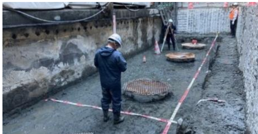
止水対策後の仮締切内の状況（写真2）
