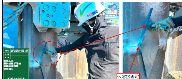
4. 添接板溶接時の仮固定用磁石
