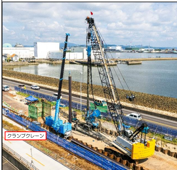
3. 打設済みの鋼矢板上を自走できるクランプクレーン
