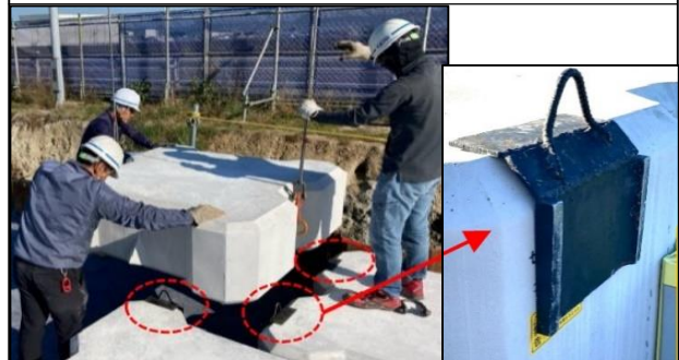
4. 添接板溶接時の仮固定用磁石
