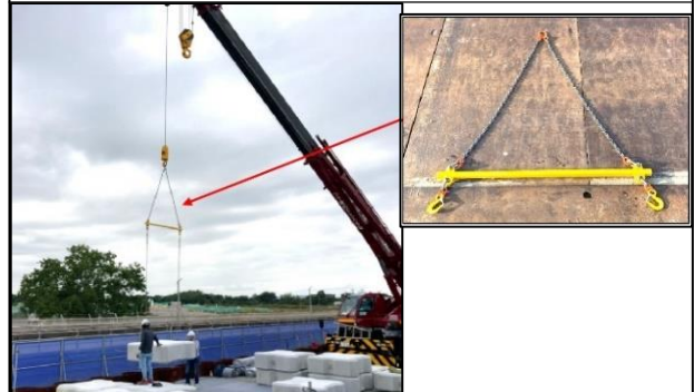
2. 被覆コンクリートブロックの間隔保持用鋼製当て物
