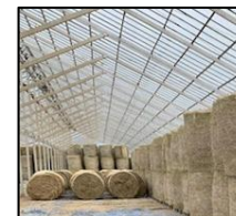
簡易倉庫の設置
