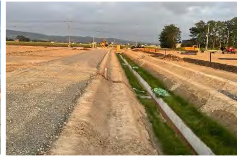
大型機械通行対応の6m級耕作道路と十分な深さが確保された付帯明渠排水路
