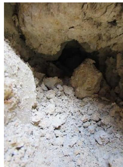
本暗渠と直交する方向に10m間隔で深さ40cmにカットドレーン施工
