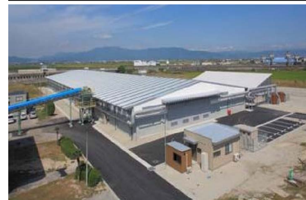
汚泥コンポスト化施設
