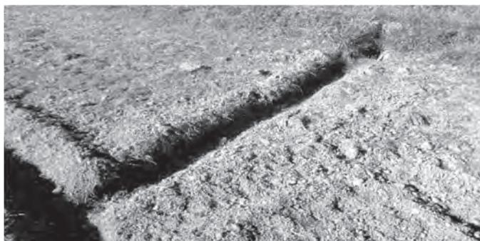
写真 2. 排水溝まで連結した様子
