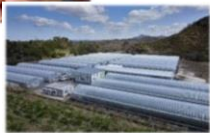
・町が整備したリースハウス
