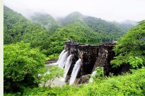
大正年間にマルチプルアーチ構造を採用して築かれた農業用ため池で、長い年月の間、風雨にさらされた堤体は、中世ヨーロッパの古城を偲ばせる偉容と風格を感じさせます。
