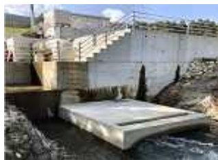
発電所・放水口
