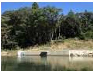
取水部取水口
