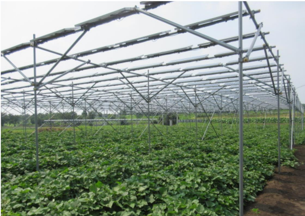
露地の畑の上部にパネルを設置
