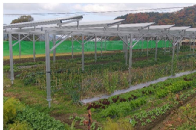
発電設備の外観
