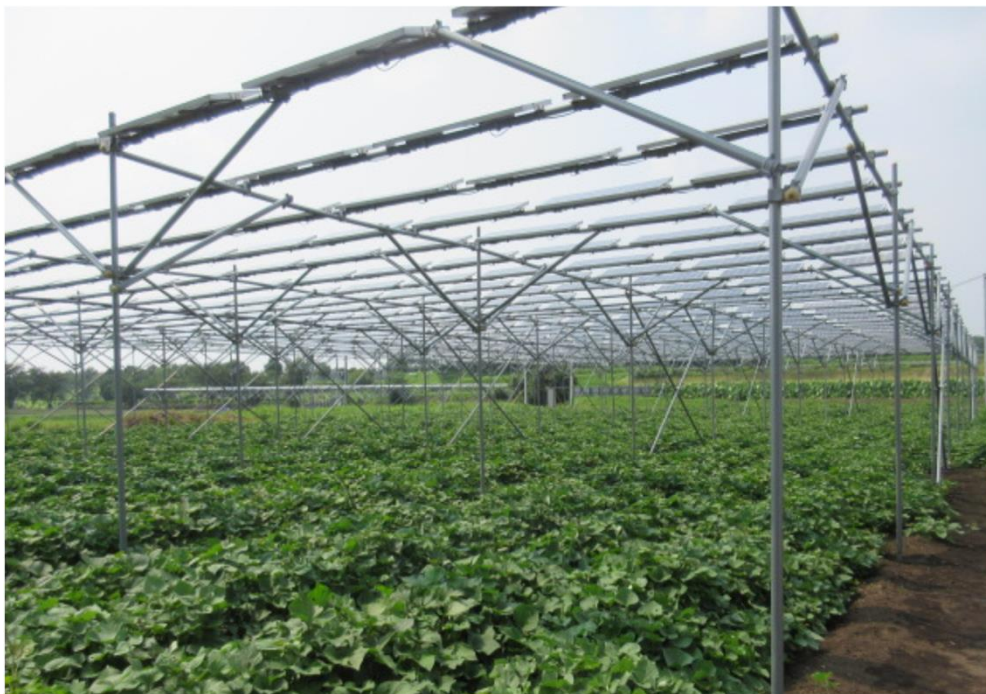
露地の畑の上部にパネルを設置
