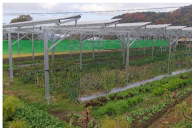
発電設備の外観
