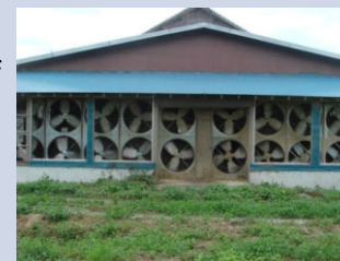
Exhaust fan on barn wall
