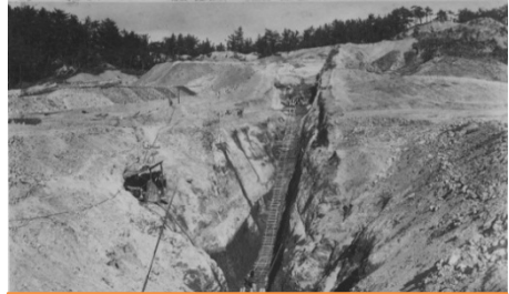
堤体の中心部。刃金土を入れるために 人力で12m以上掘っている。
