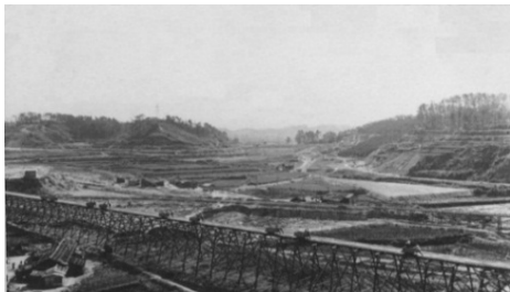
木製栈橋の上に資材を運ぶ 人力トロッコ
