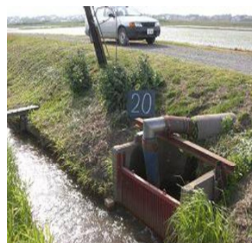
写真 32. 小型反復利用ポンプによる排水路からの揚水
