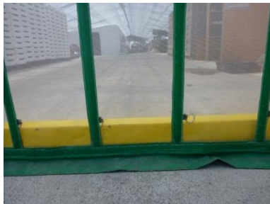
動物等の侵入防止対策の例
