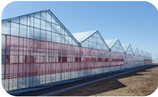
【ICTを活用した研修センターの外観】
