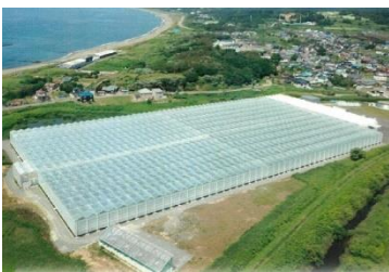
【ハウス施設の全景】
