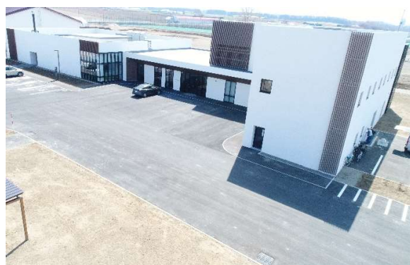
施設の外観（アグリハートセンターより提供）
